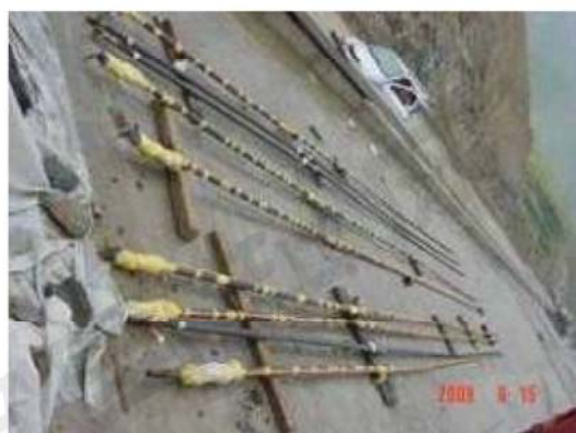
图 2-7 传感器安装完成
