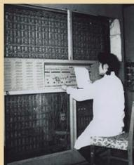
↑1958年计算机研制的八一型电子管计算机(103架)
